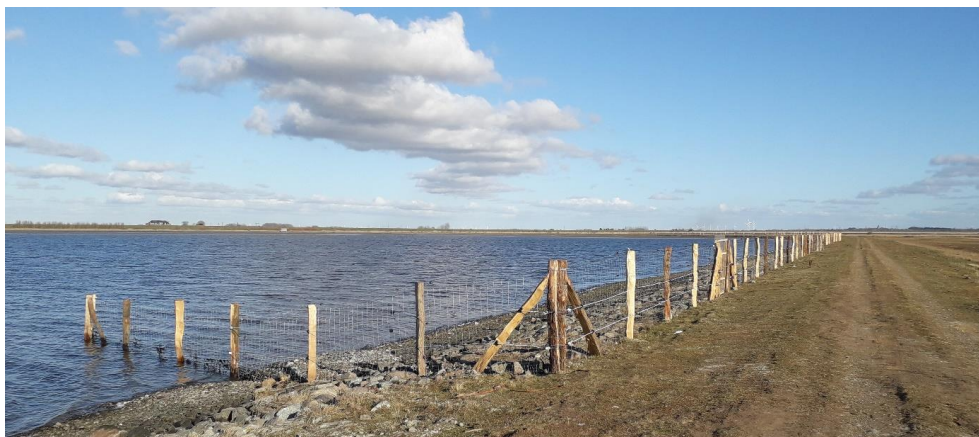
Abbildung 11 Neuer Anti-Prädatoren-Zaun im Osten des nördlichen Arlau-Speicherbeckens mit Blick nach Nordosten auf die Salzwasserlagune. Das Ende des Zauns entspricht der Position in Abbildung 10 („Ende mobiler Fuchszaun der letzten Jahre“).
