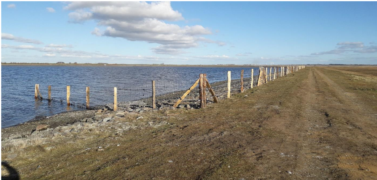
Abbildung 30 Östliches Ende des festen Prädatoren-Schutzzaunes im nördlichen Arlau-Speicherbecken. Der Zaun endet nach Norden hin in der Salzwasserlagune, um ein Umlaufen zu verhindern. Foto: D. V. Cimiotti
